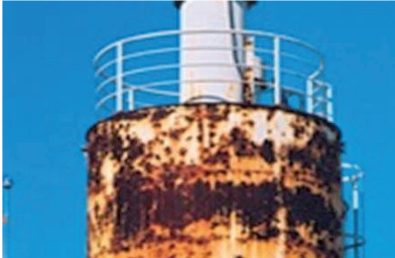
Slika 1. Opća korozija
