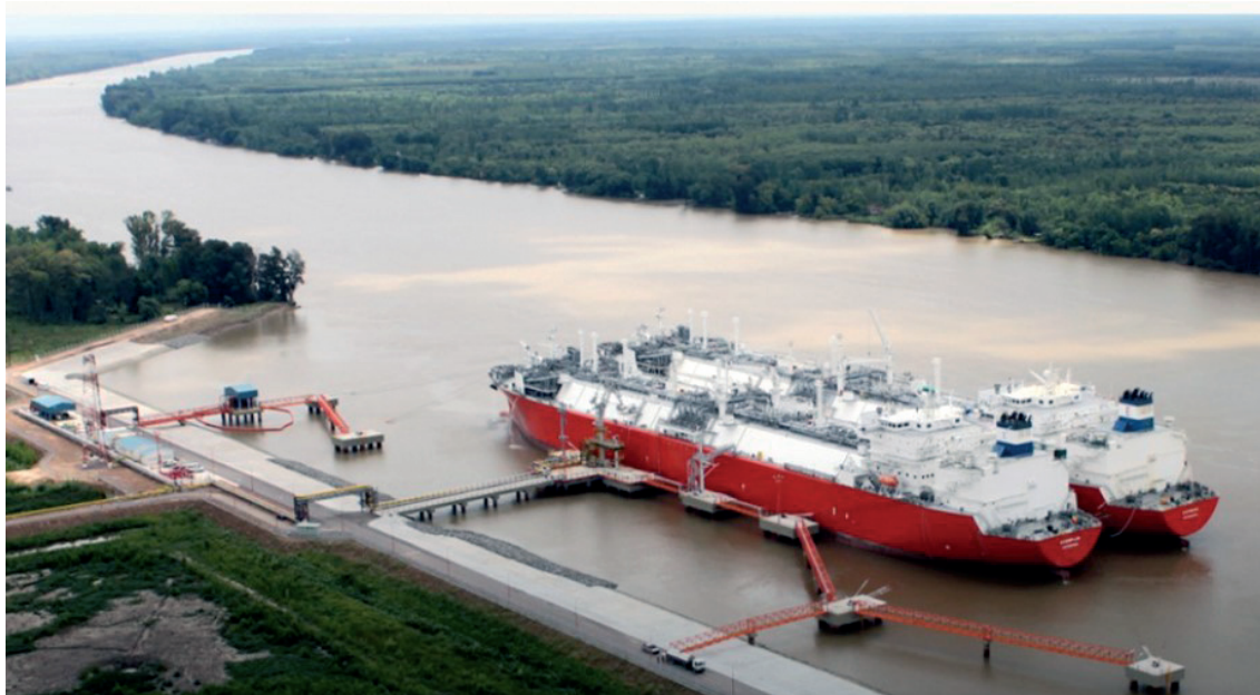
Slika 1. Obalni plutajući LNG terminal (Escobar) IZVOR: http://www.excelerateenergy.com (posjećeno 7. IV. 2018.)
